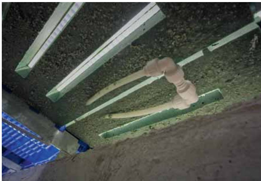
Composiet vloerdelen, hier van onderaf gezien, combineren een aantal voordelen van kunststof en betonnen roosters in een nieuw product. FOTO: MATTHIJS VERHAGEN
